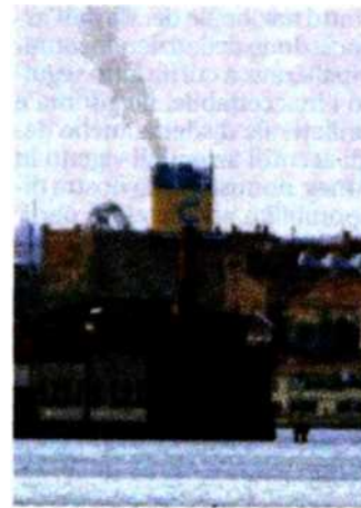
Il camino della Fascinosa
